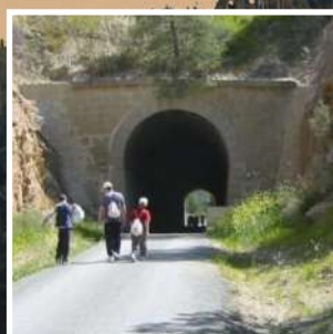
(el túnel arranca del suelo verticalmente y una bóveda de semicírculo cierra el túnel)
